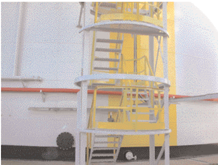
Рис. 1. Лестницы и переходы PVC-10000 № E29 после окраски.
