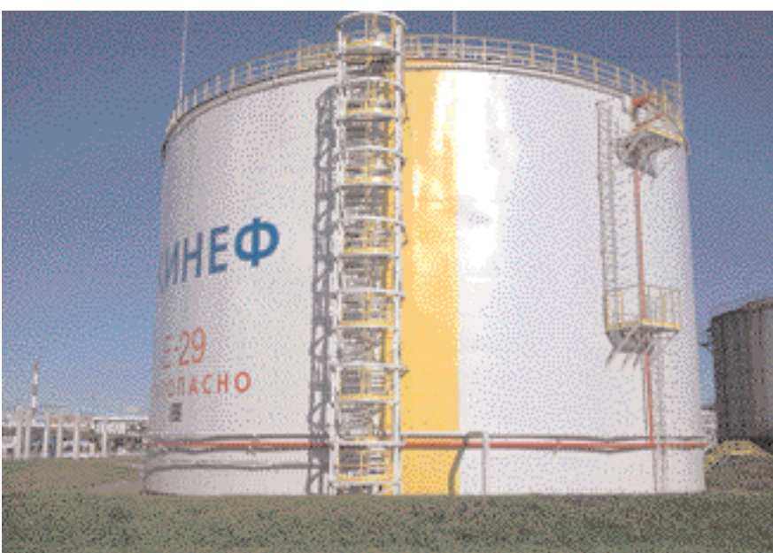
Рис. 2. PBC-10000 № E29 после окраски.
